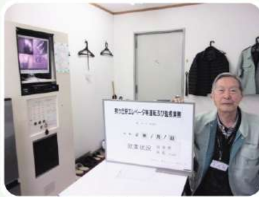
泉ヶ丘駅前設備運転監視室
