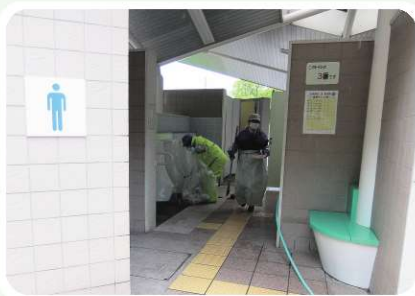
トイレ清掃作業
